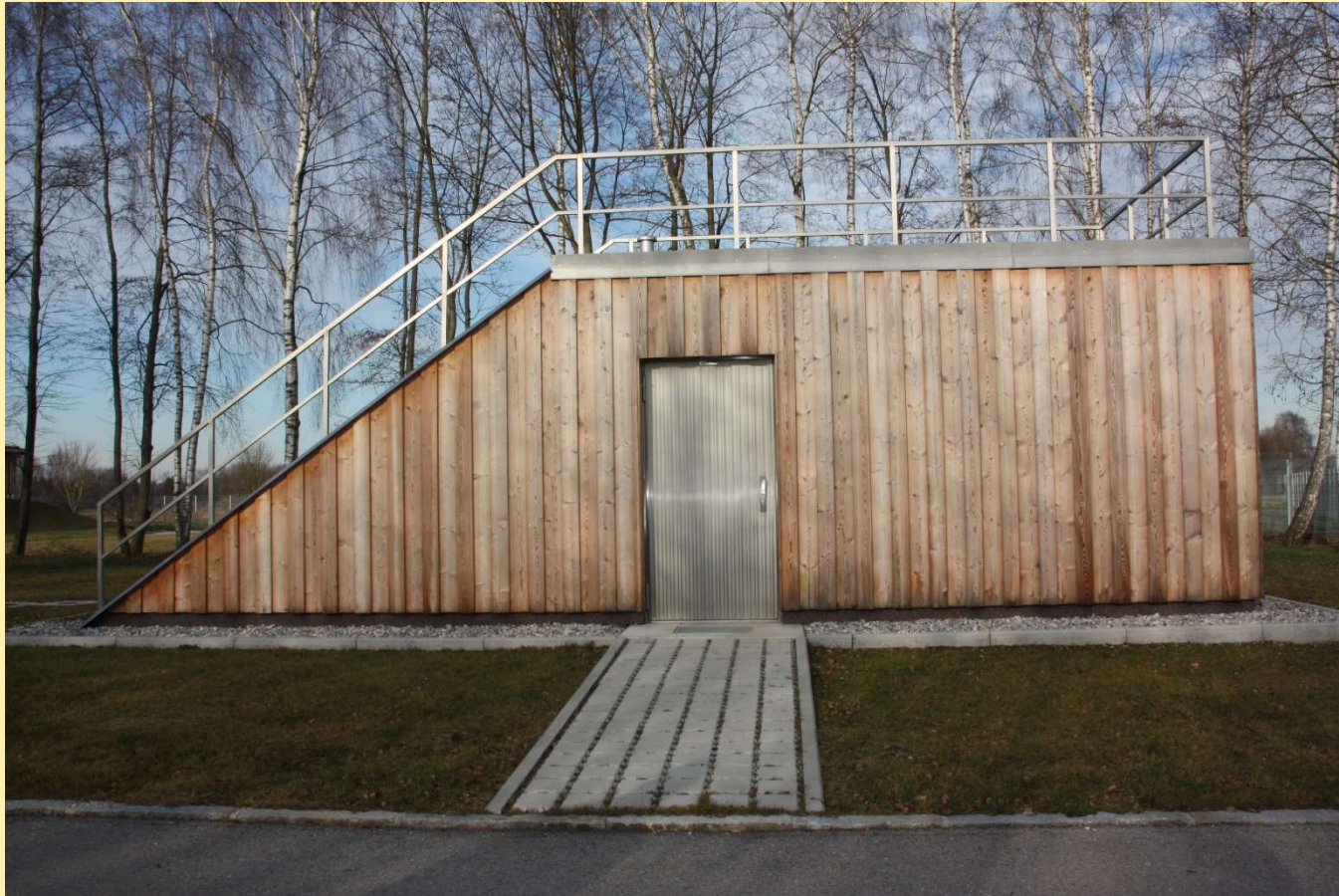
Sanierter Tiefbrunnen 1 auf dem Wasserwerksgelände
