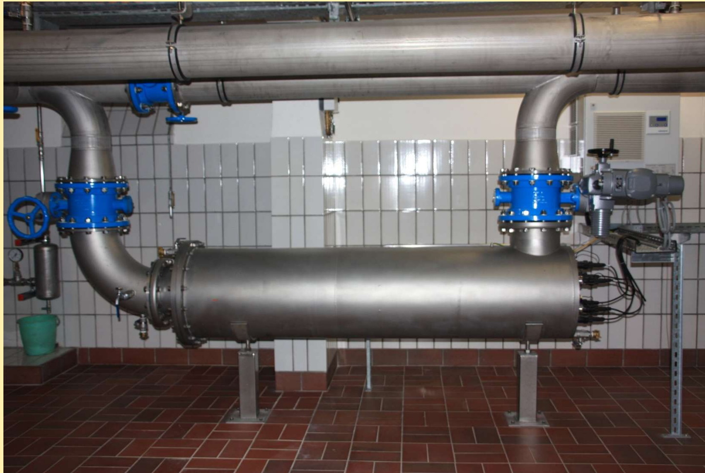
UV-Anlage als Präventivmaßnahme gegen Verkeimung
