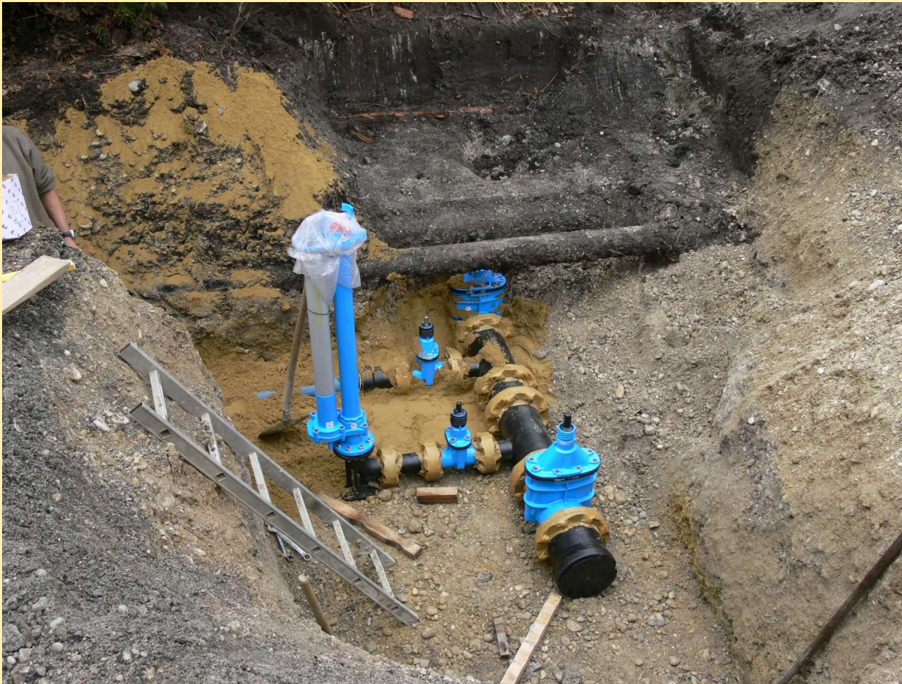
Neue Hauptleitung im Bau
