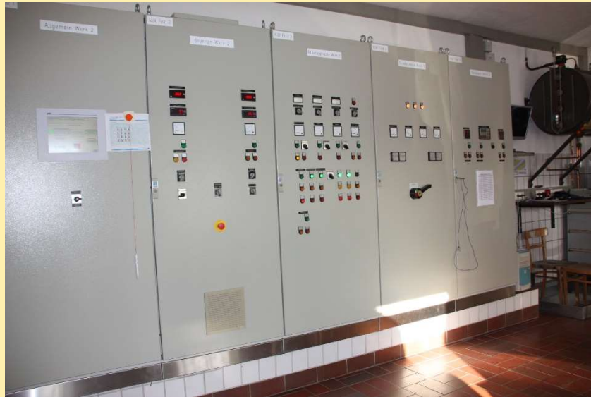
Schaltzentrale Wasserwerk
