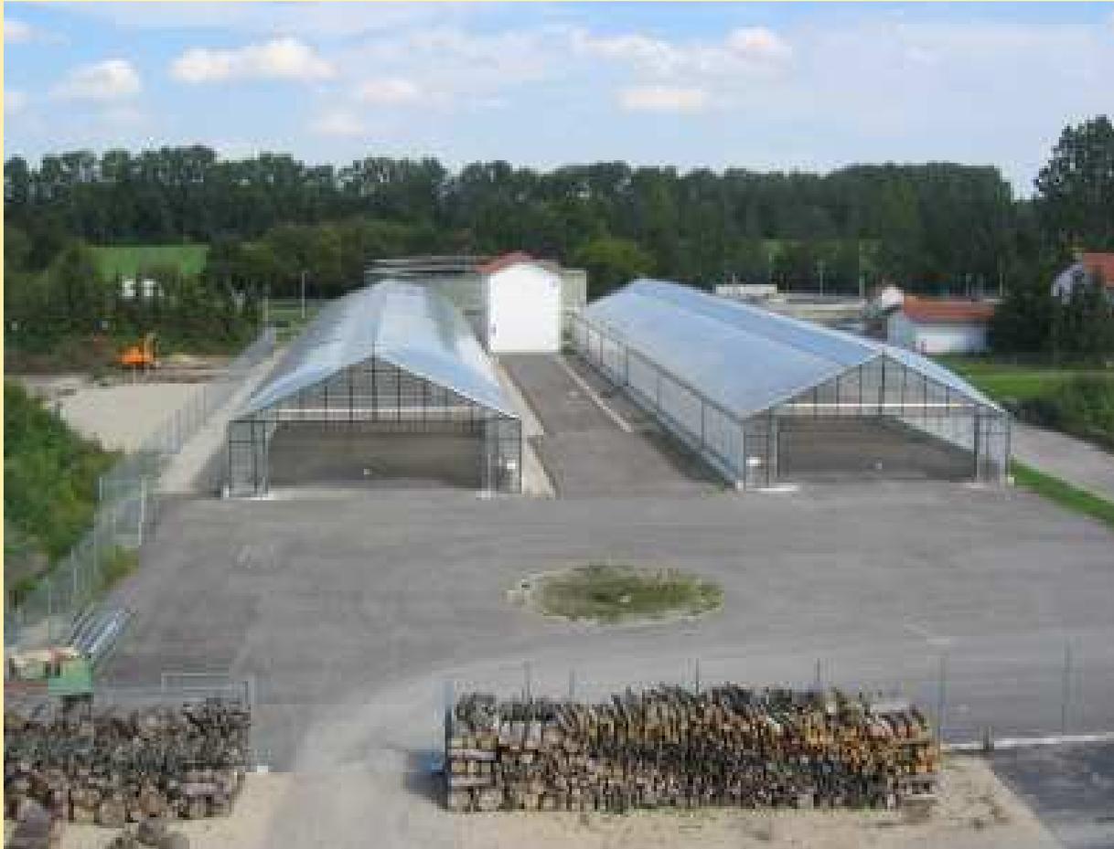
Solare Trocknung von Klärschlamm
