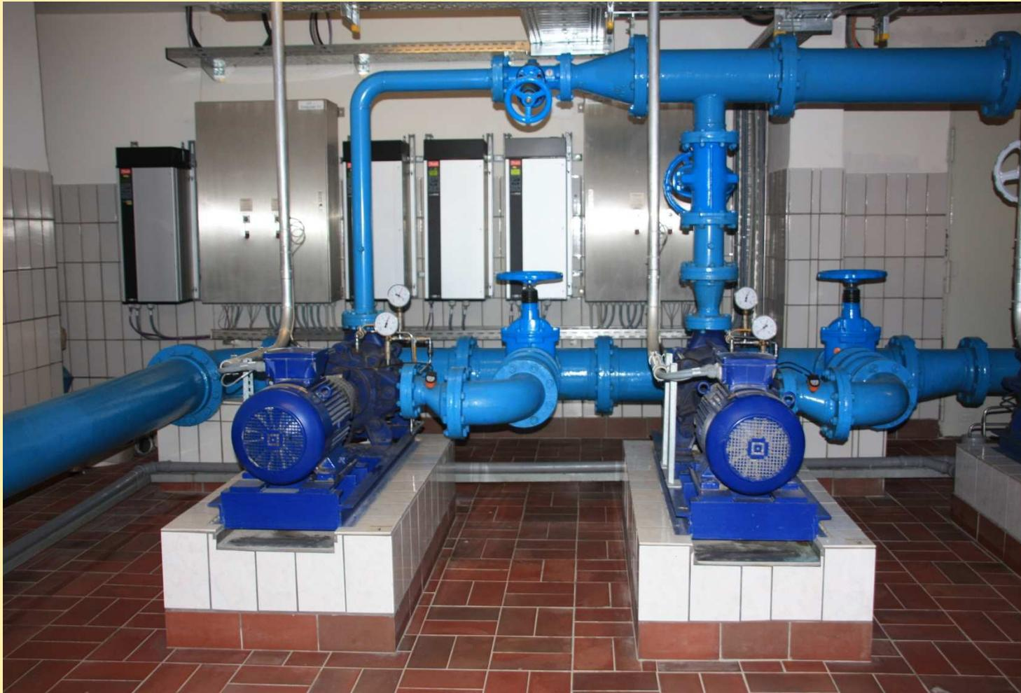
Druckpumpen fördern das Wasser aus dem Speicher ins Wasserrohrnetz
