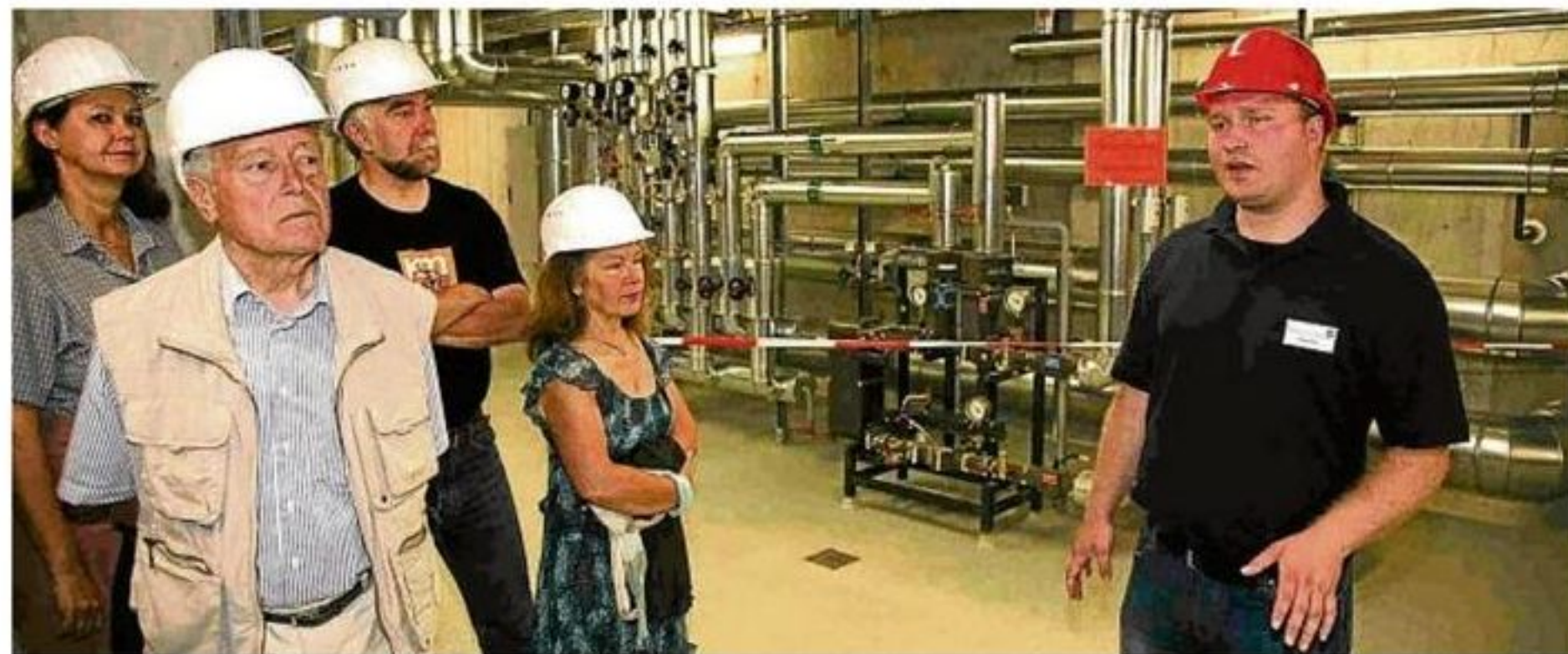
Neugierige Gäste führte der stellvertretende Werksleiter Stefan Peisl (rechts) durch das Heizkraftwerk.
