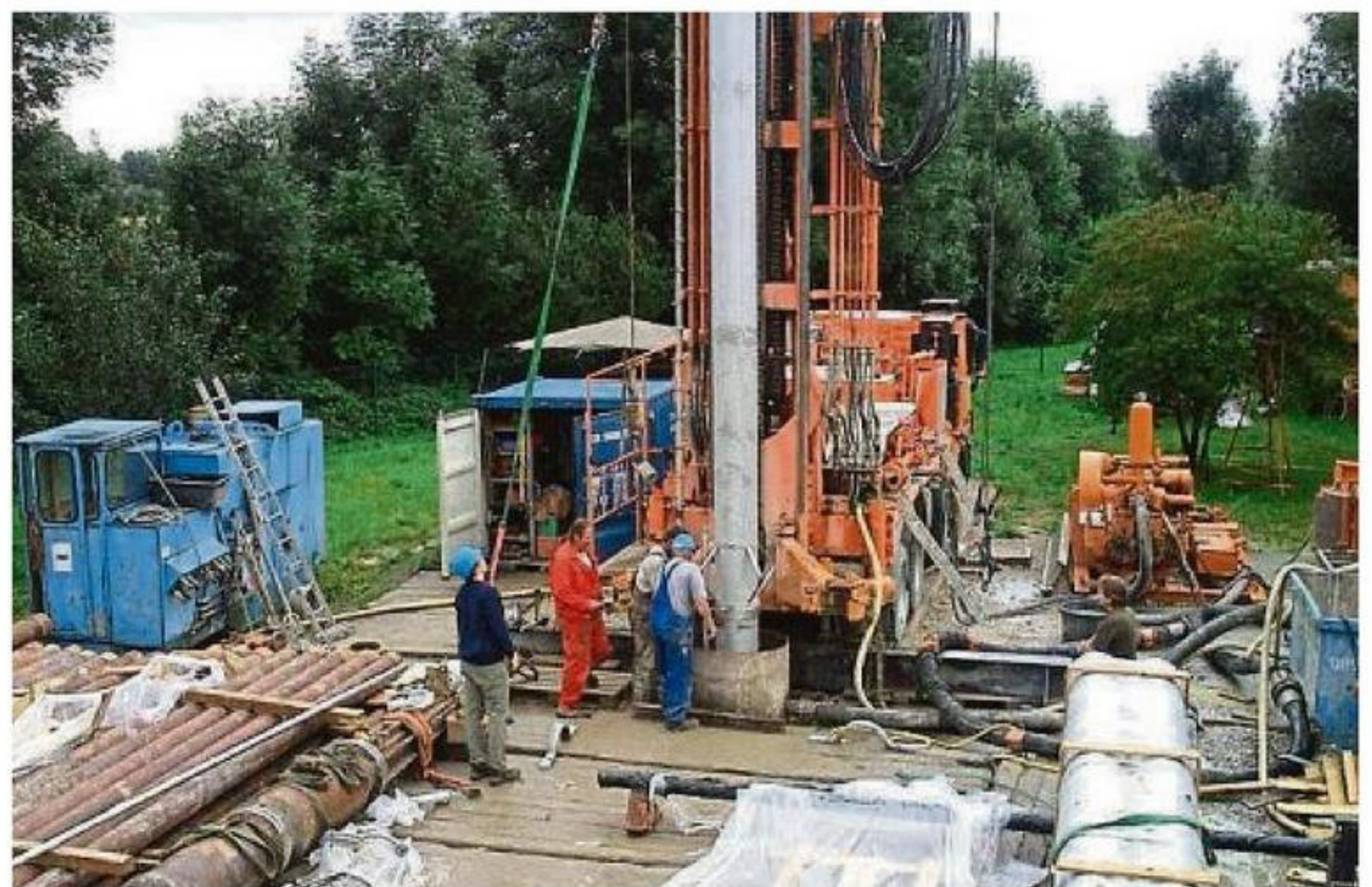
Fünf Brunnen versorgen Karlsfeld mit Trinkwasser: Derzeit finden im Wasserwerk aufwendige Brunnenarbeiten am vierten Tiefbrunnen statt.
