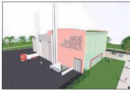
Über einen asphaltierten Ladehof liefern Lastwagen pro Tag im Schnitt 20 Tonnen Holzhackschnitzel als Heizmaterial an.
